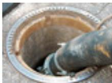
Con un diametro di soli 547 mm, la pompa può essere impiegata in quasi ogni pozzetto. Lo scarico verticale e centrale e l'ottimo bilanciamento garantiscono, inoltre, la posizione verticale della pompa.
